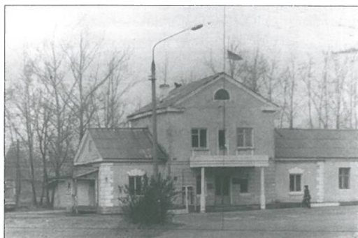
Здание поссовета. Опалиха. 1950-е годы
