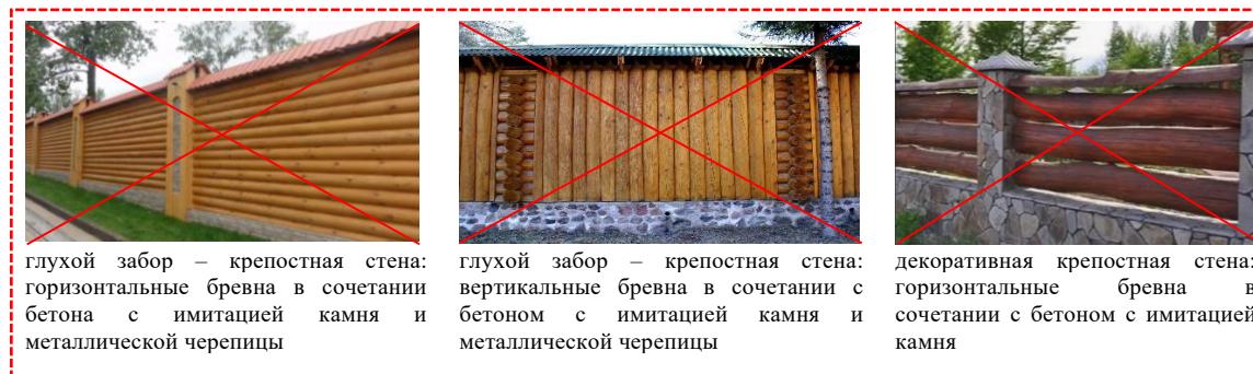
рис. 2.13 «пример внешнего вида бревенчатых заборов, не допускаемых к размещению вдоль «вылетных» магистралей»
