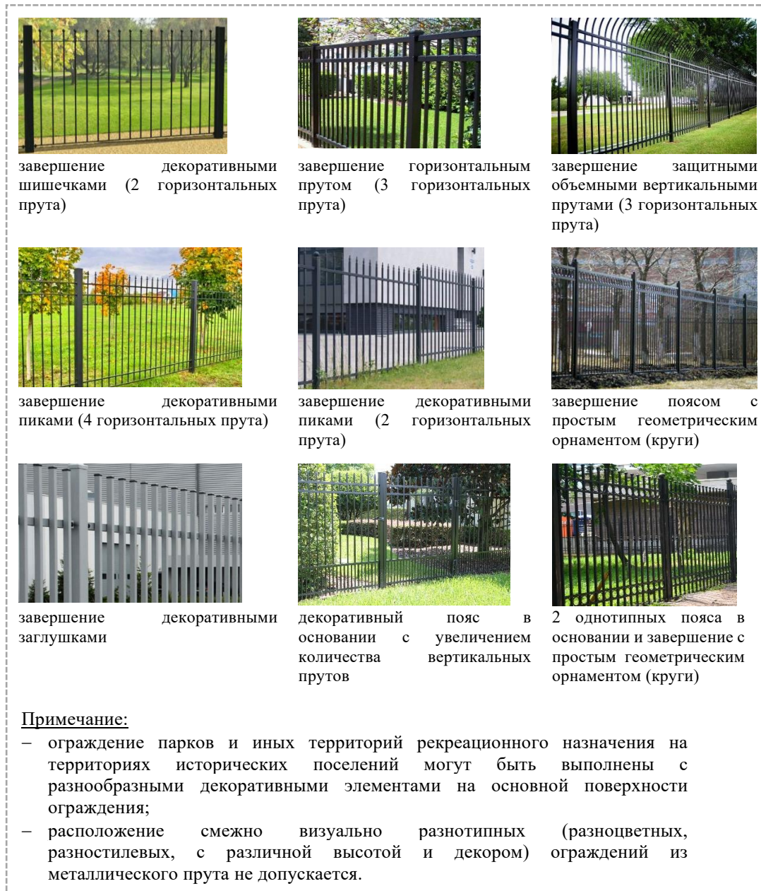
рис. 2.40 «примеры допустимых ограждений из металлического прута»
