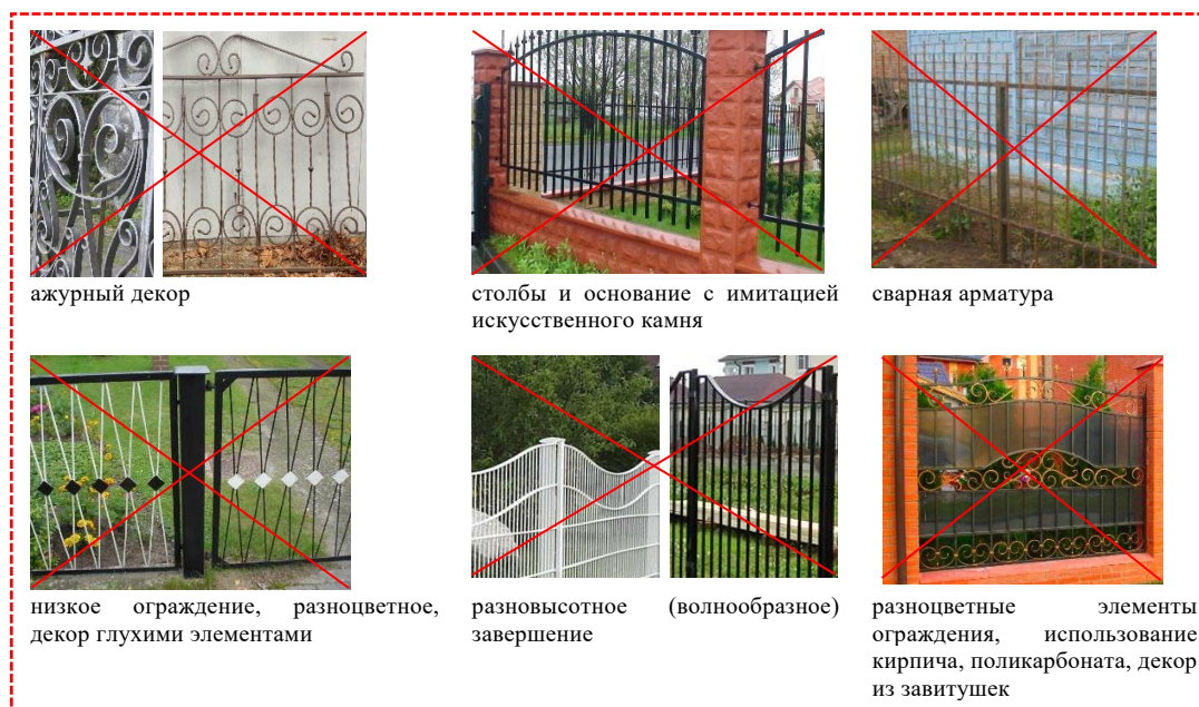
рис. 2.39 «примеры недопустимых ограждений из металлического прута»
