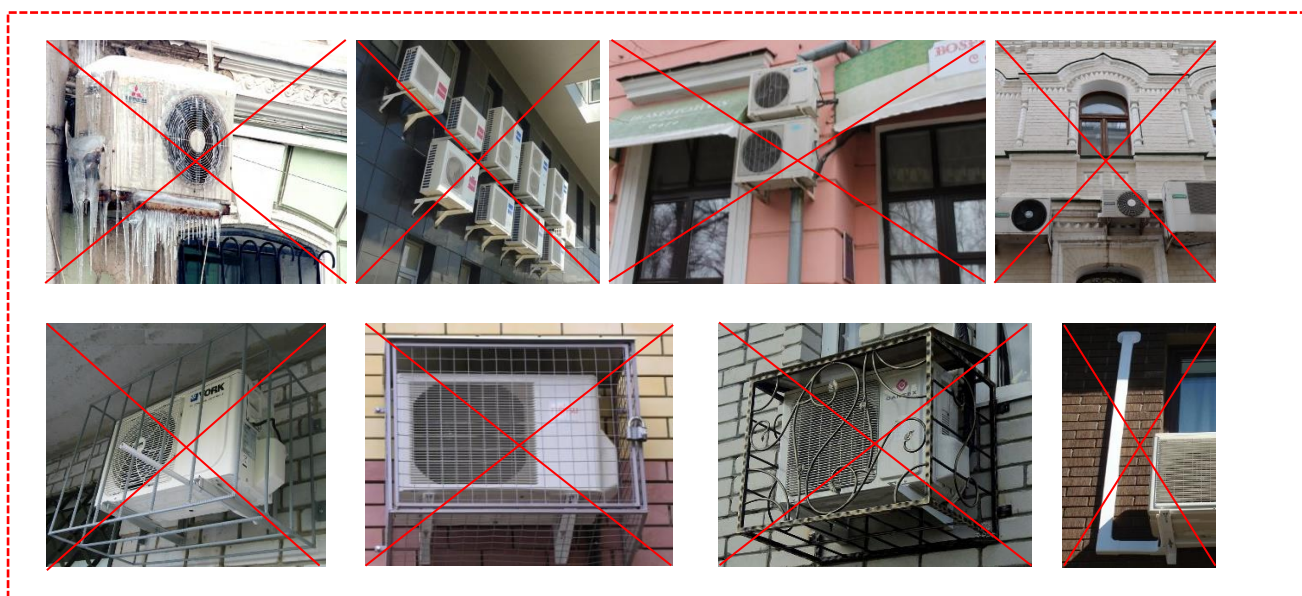
рис. 8.13 «примеры недопустимого размещения внешних блоков кондиционеров»
