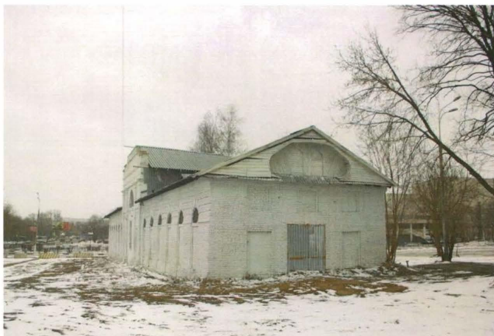
2. Вид на конюшню с юго-востока.
