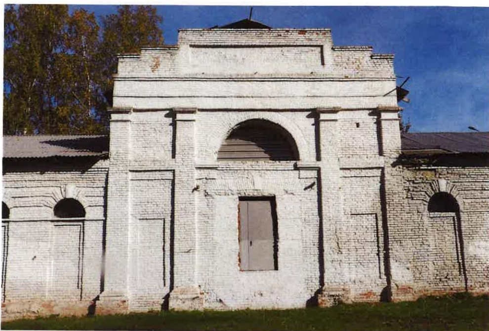
9. Вид на центральную часть южного фасада.
