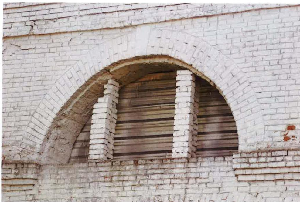
12.Фрагмент центральной части северного фасада.
