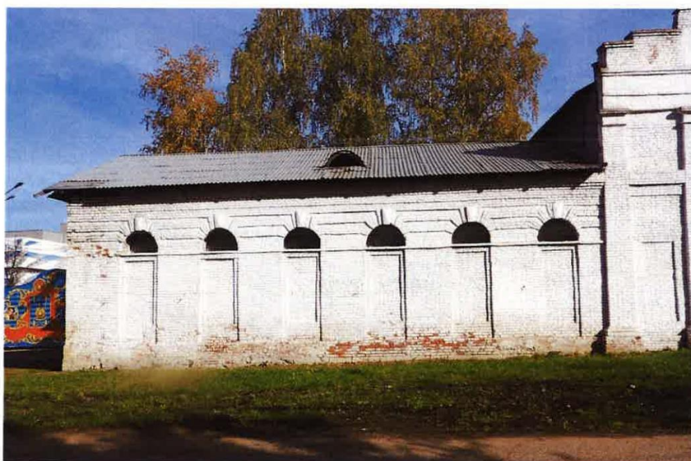
8. Вид на западную часть южного фасада.
