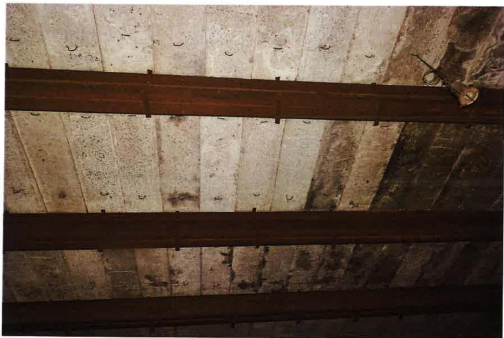
16. Вид на перекрытие в западной части здания.
