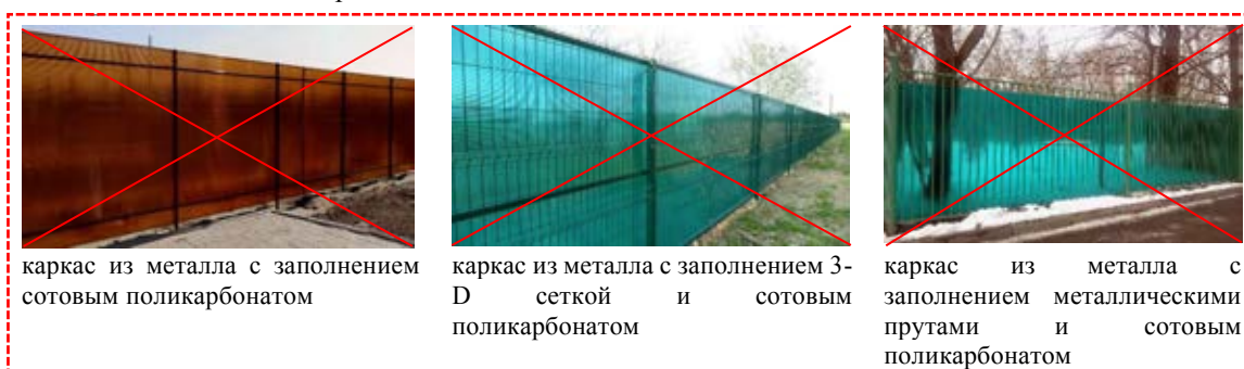
рис. 2.11 «пример внешнего вида заборов из поликарбоната, не допускаемых к размещению вдоль «вылетных» магистралей»
