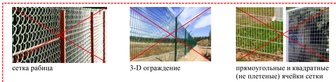
рис. 2.27 «примеры недопустимых ограждений из проволочной сетки»
