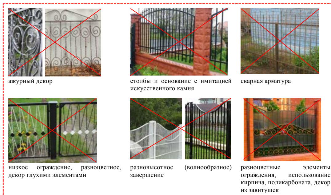
рис. 2.39 «примеры недопустимых ограждений из металлического прута»
