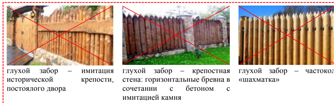
рис. 2.15 «пример внешнего вида частокола, не допускаемого к размещению вдоль «вылетных» магистралей»
