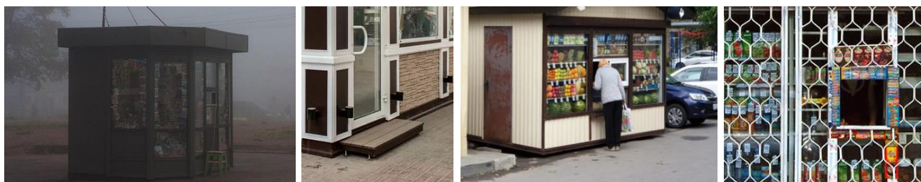
отсутствие средств наружного освещения нет доступа для МГН обслуживание посетителей с проезжей части закрытие витрин решетками закрытие витрин панелями
